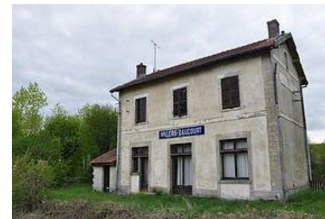
Ancienne gare de Villers Daucourt (source Wikipédia)
